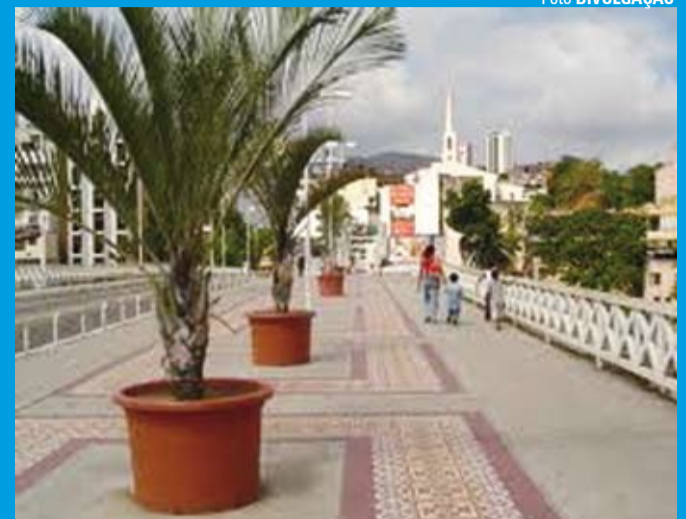
A ponte municipal Fernando de Abreu liga a rua Vinte e Cinco de Março à rua Moreira
